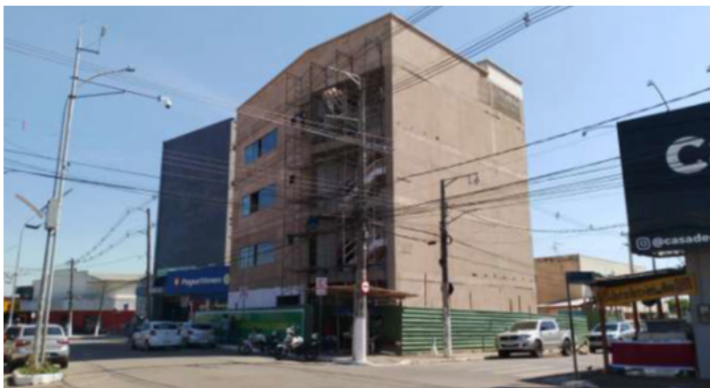
Figura 1 - Obra do PROCON – imóvel do ACREPREVIDÊNCIA
