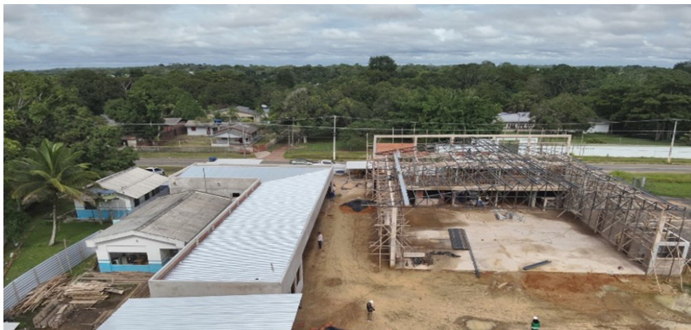
Figura 13 - Construção do 2º Batalhão da PM, Rio Branco
