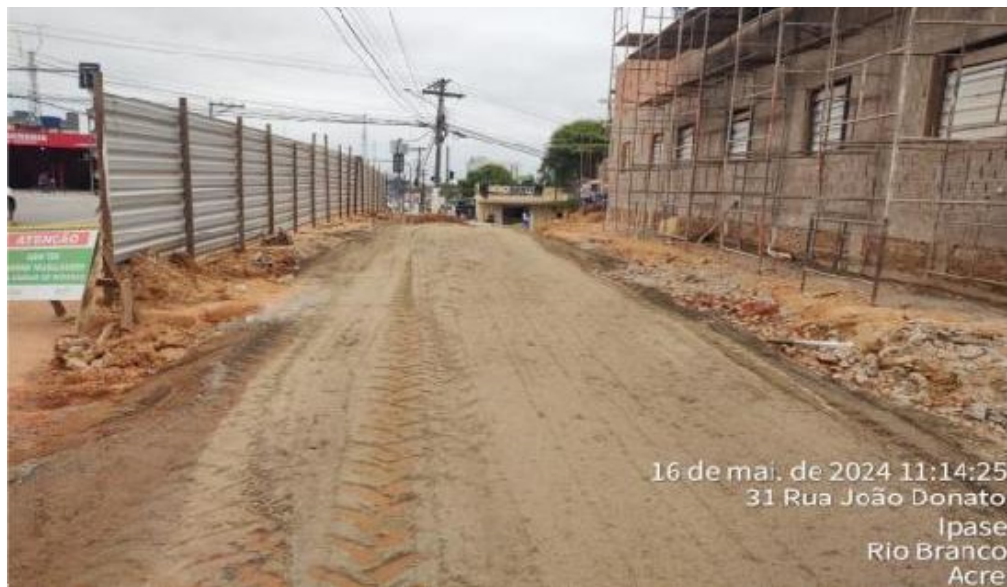
Figura 90 Demolição prédio da SEGOV
