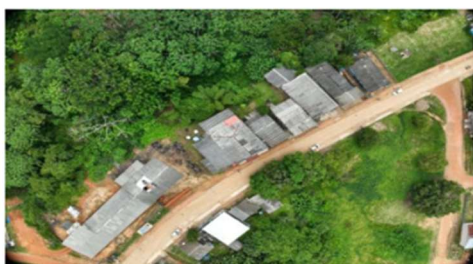
Imagem 5 IMAGEM AÉREA - TRECHO DE CALÇADA EXECUTADA
