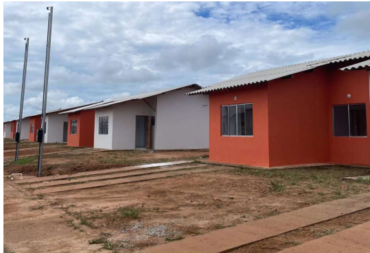
Figura 21 - Construção de 393 Uh na Cidade do Povo
