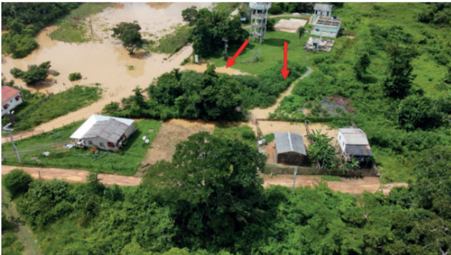
Figura 12: O nível do Rio Acre alcançou o terreno da ETA.
