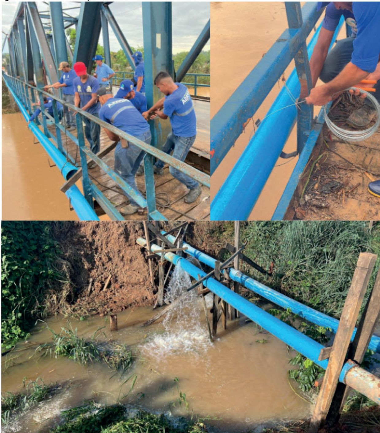
Figura 6: Troca do cabo de aço e adutora.
